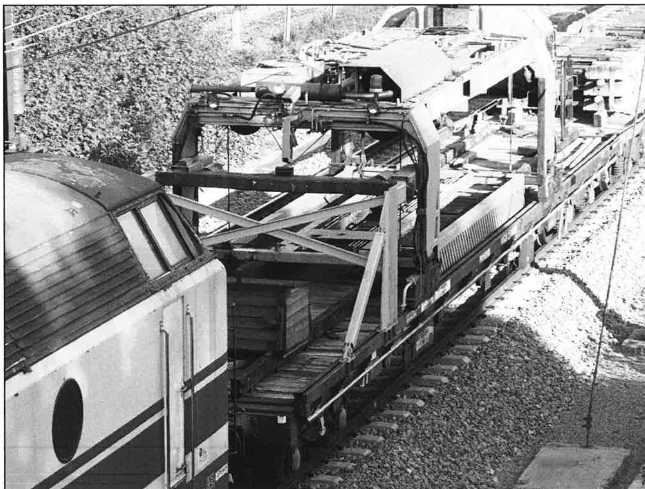
Renouvellement des traverses sur la ligne 161 entre Gembloux et Namur : train de travaux sur la voie vers Gembloux à hauteur du pont de Bovesse (photo C. Carpet, 25 avril 2011).
